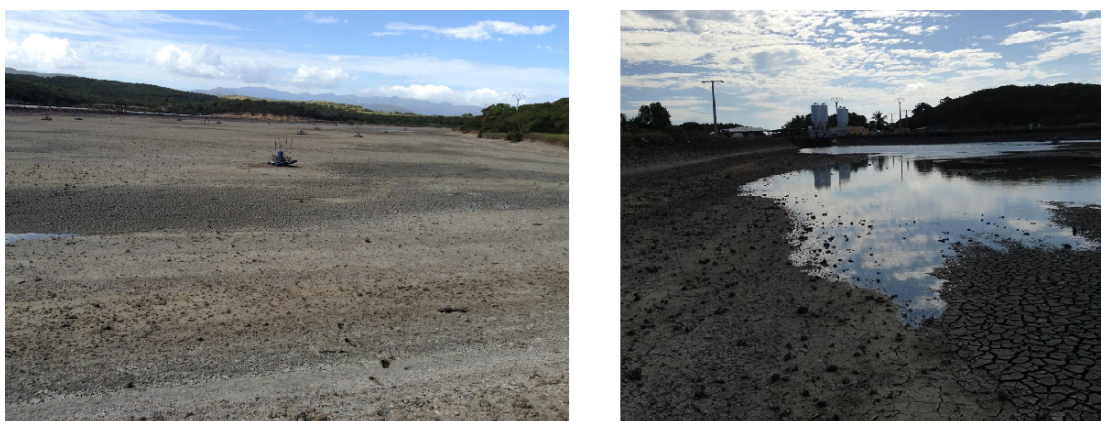
Fig. 4.4 l'assec d'un bassin avant son remplissage.
