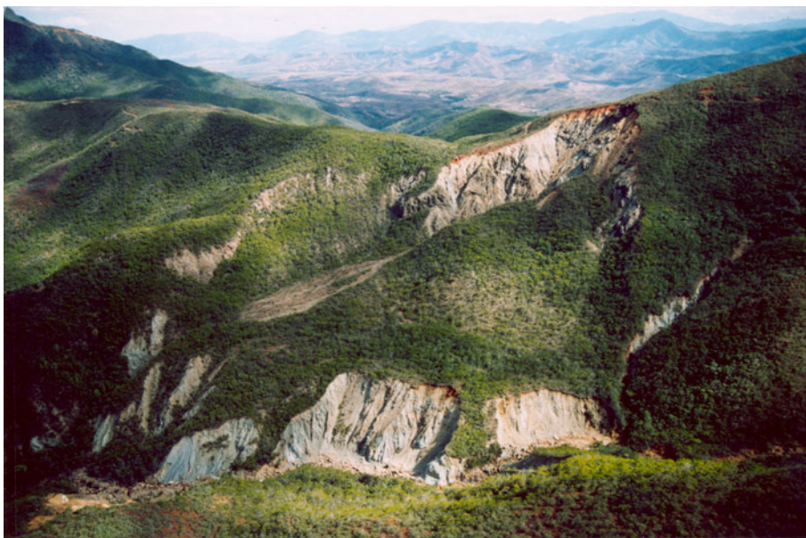
Illustration I.4.1 G: Glissement pluri-hectométrique en milieu serpentineux, massif du Kopéto. Photographie B. Pelletier (SLN).
