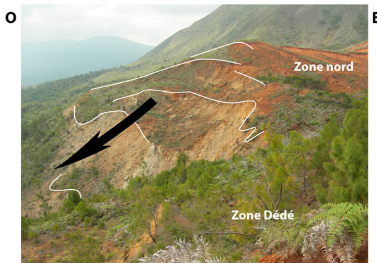
Illustration III.4.2 F - Le glissement rocheux m 5 « Mille et Berton » en 2008, au front de la zone nord.
