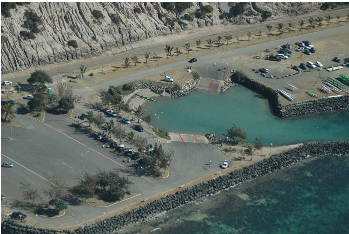
Photo 1 de la Côte Blanche, à Nouméa montrant les deux rampes se faisant face : la première côté route est suffisamment large pour permettre à deux remorques d'opérer simultanément, celle côté du lagon peut accueillir trois remorques.
