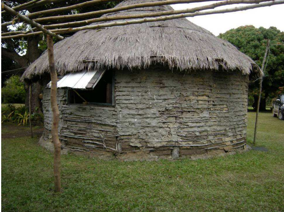
Photographie 10 - Case en torchis recouvert d'un peu de ciment
