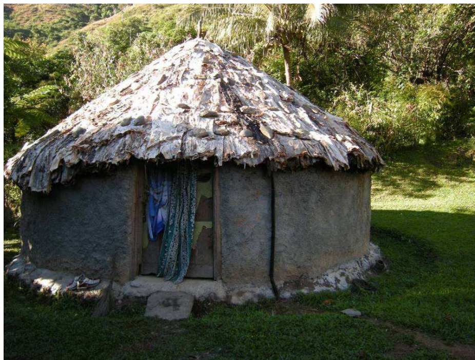
Photographie 9 - Case en béton au toit d'écorces de niaouli
