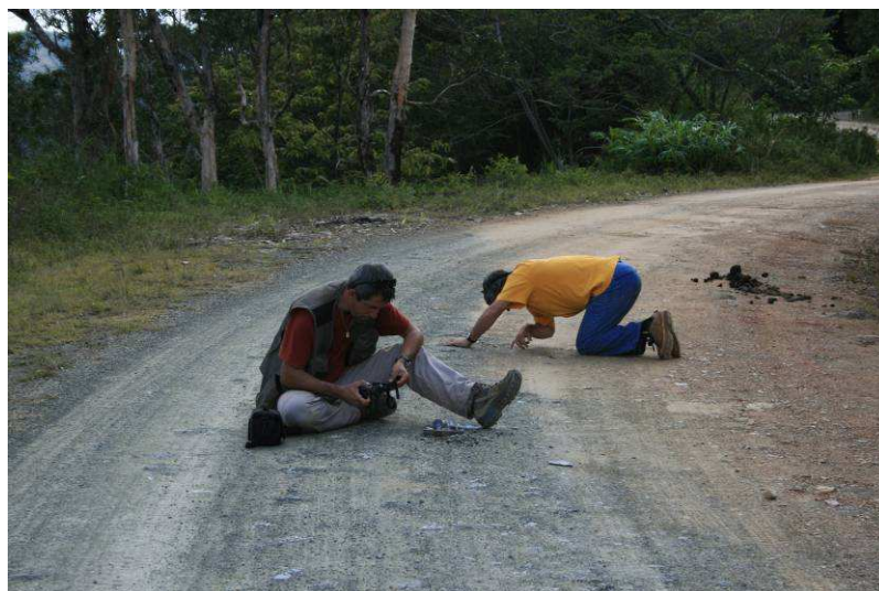
Photographie 62 – Route avec, en premier plan, un revêtement de serpentinite
