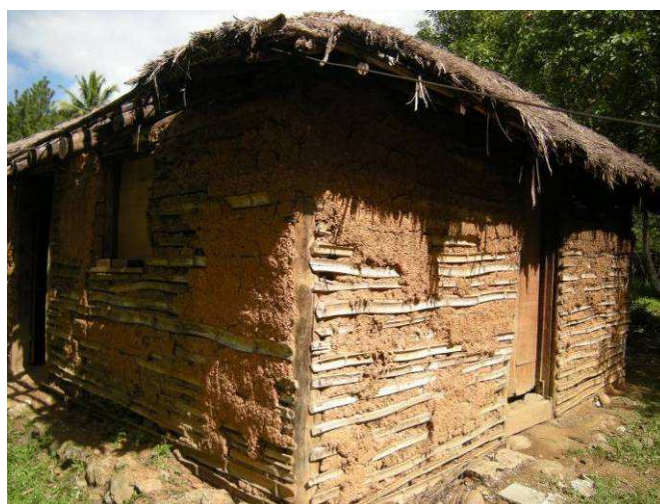
Photographie 4 - Case en torchis à ossature en bambou
