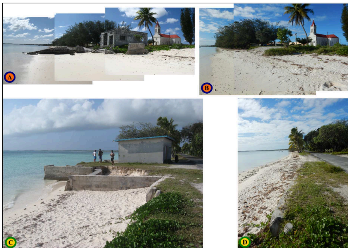
Figure 97 : Ouvrage en ruine et bâtiment abandonné bloquant particulièrement le transit sédimentaire longitudinal. Aménagements retirés au cours de la période d'étude (premier trimestre 2016). (Photographies : Matthieu Le Duff).
