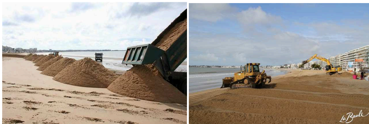
Figure 165 : Exemple de rechargement en sable d'une plage, La Baule, 215 000 m 3 . Photographies : Ouest France (2004).
