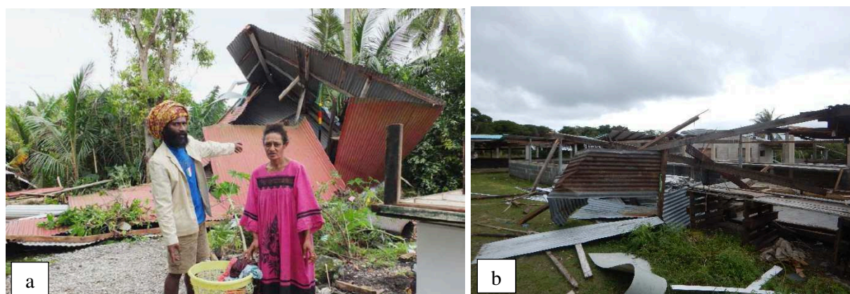
Figure 65 : Dégâts aux structures bâties en tôle. a : Lifou, Luengoni en juin 2012 (photographie : Angélique Rouquier) – b : Lifou, Qanono en avril 2017 (photographie : Matthieu Le Duff).
