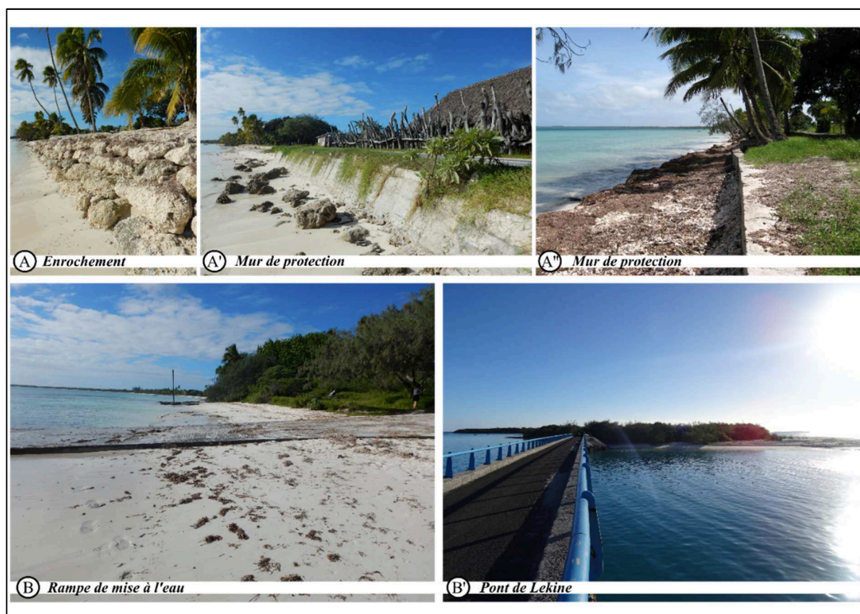
Figure 96 : Photographies de quelques ouvrages présents sur les sites d'études. (Photographies : Matthieu Le Duff).
