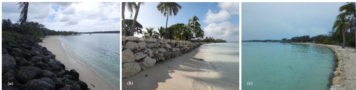
Figure 163 : Exemples d'ouvrages longitudinaux à Ouvéa. (a) culée du pont de Lekine ; (b) enrochement de Takedji ; (c) enrochement de Lekine. (Photographies : Matthieu Le Duff).
