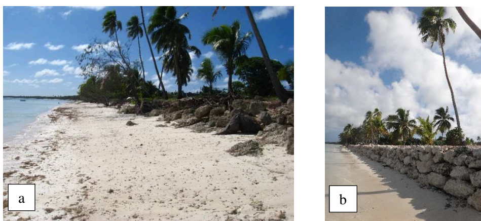
Figure 158 : a/ Enrochements en ruine en mai 2015. b/ Au cours du premier trimestre 2016 ils sont renouvelés et prolongés sur une longueur de 200 m en direction du nord. (Photographies : Matthieu Le Duff).
