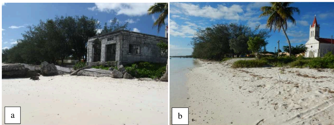
Figure 156 : Ouvrage bloquant le transit sédimentaire en face de l'église de Saint-Joseph. Ouvrage retiré au cours du premier trimestre 2016. a/ Octobre 2015 ; b/ Avril 2016. (Photographies : Matthieu Le Duff).
