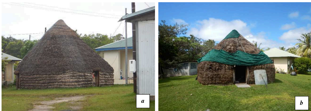
Figure 34 : Dispositif de protection des cases, adaptation de la technique traditionnelle avec du grillage (a) Tribu de Qanono, district de Gaïca, Lifou ; ou des bâches, parfois des filets de pêche (b) Tribu d'Ahmelewedr, district de Lōsi, Lifou. (Photographies : Matthieu Le Duff).
