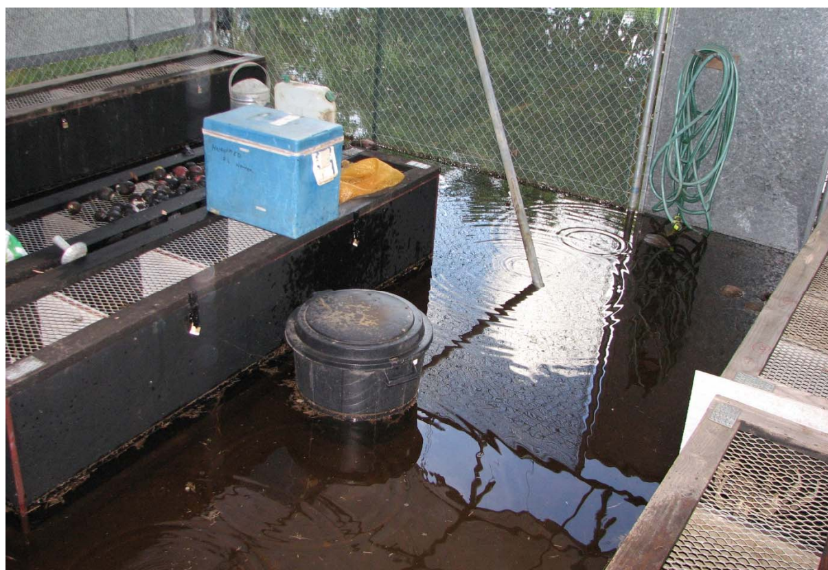
Figure 45 : dégâts des eaux, week-end pascal 2016
